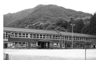
廃校を舞台としたアートプロジェクト「みんなの学校」の舞台となる旧湯屋小学校
